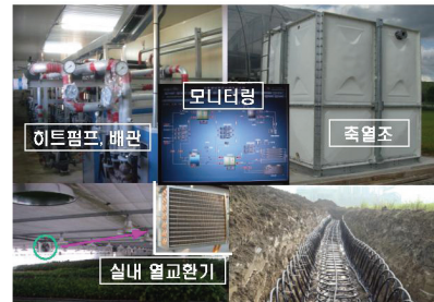
〈현장 설치 광경(경남 진주)〉
