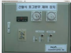
간헐식 포그분무 제어장치
